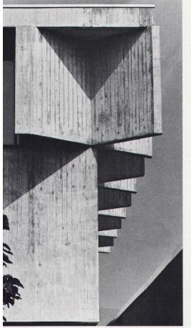
einem hohen, über die Fensterfronten auskragenden Kassettenträgersystem, welches sich auf die Aussenwände abstützt. Die Aussenwände lasten auf wenigen markanten Pfeilern. Die ganze Konstruktion unterstreicht so den sakralen Charakter des Bauwerkes. Die Träger geben der Decke und dem Innern der Kapelle zugleich eine stark dreidimensionale Ausdruckskraft.
