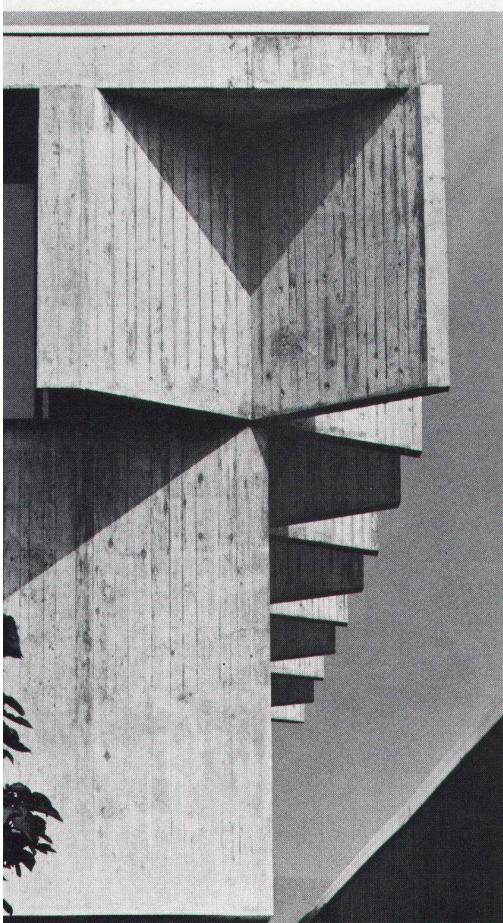
einem hohen, über die Fensterfronten auskragenden Kassettenträgersystem, welches sich auf die Außenwände abstützt. Die Außenwände lasten auf wenigen markanten Pfeilern. Die ganze Konstruktion unterstreicht so den sakralen Charakter des Bauwerkes. Die Träger geben der Decke und dem Innern der Kapelle zugleich eine stark dreidimensionale Ausdruckskraft.
