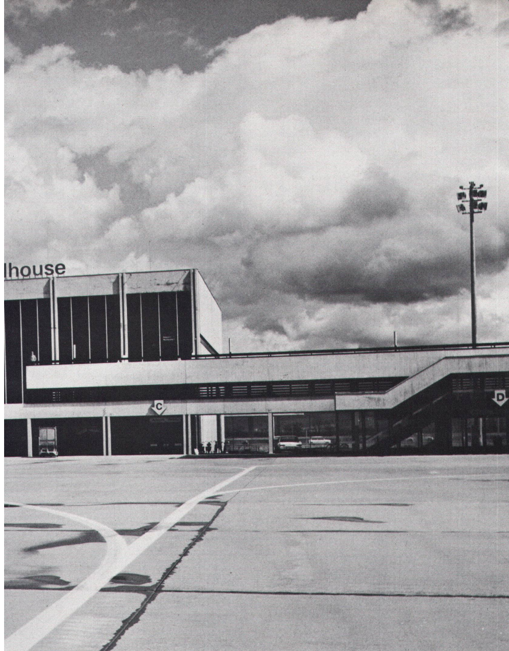
1 1. Bauetappe von der Piste her gesehen mit Erweiterungsmöglichkeiten nach links und rechts, Besucherterrassen.
