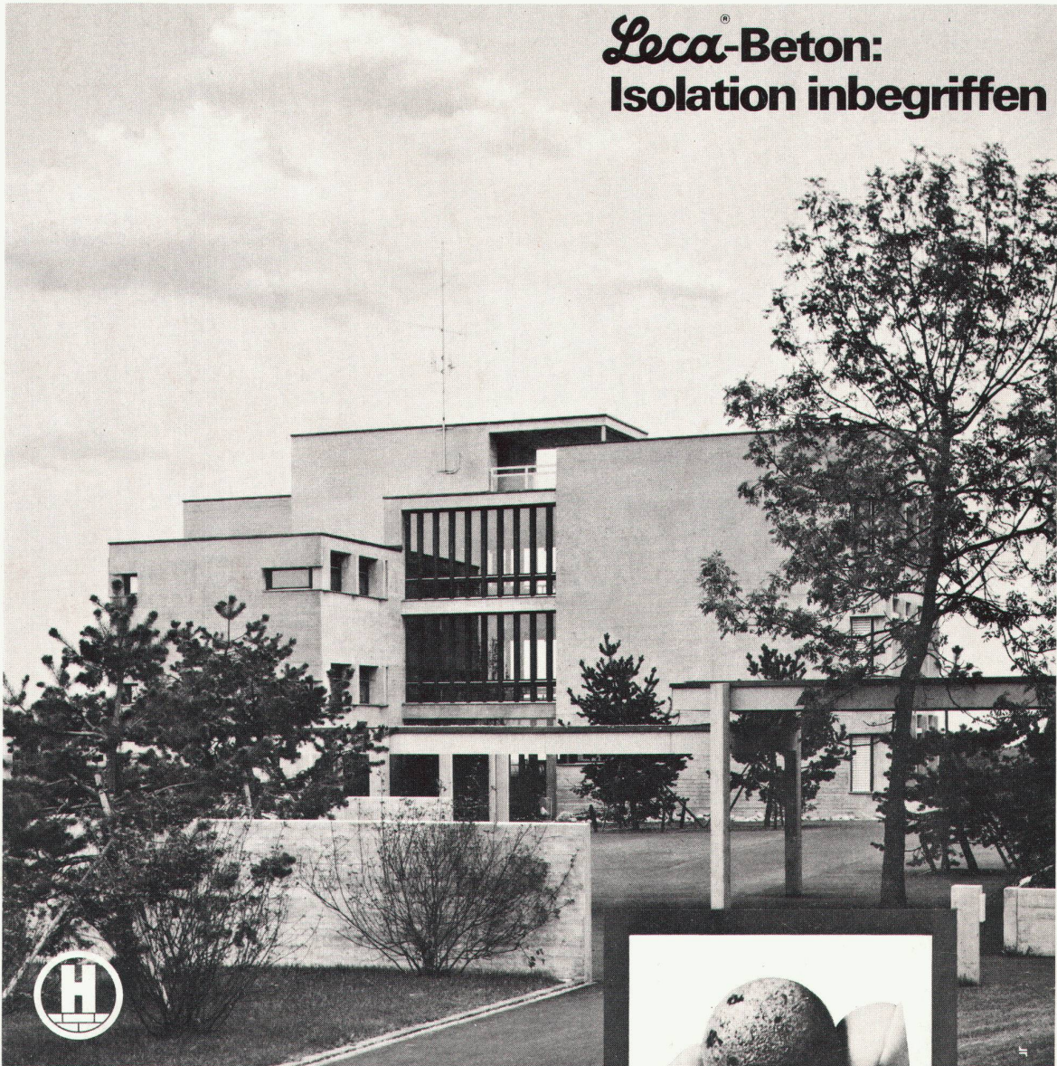
Schulhaus in Pfaffhausen aus Leca -Schüttbeton mit Sichtstruktur Planung: Bridel + Spirig, Architekten, Zürich Statik: Jacobson + Včkovski, Ingenieure, Zürich Bauausführung: H. Ochsner + Co, Bauunternehmung, Zürich
