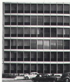
Fassadenelemente, Durch sinnvolle Kombinationen aller Fensterarten mit vorgefertigten Brüstungen und Stützen entstehen Fassadenelemente modernster Konzeption.
