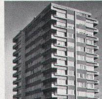
Die wasserdichte, frostbeständige und hinterlüftete Wetterhaut aus ebenen Platten ETERNIT benötigt keinen Unterhalt. Sie bildet einen optimalen Witterschutz und garantiert über alle Jahreszeiten einen gleichbleibenden Isolierwert.
