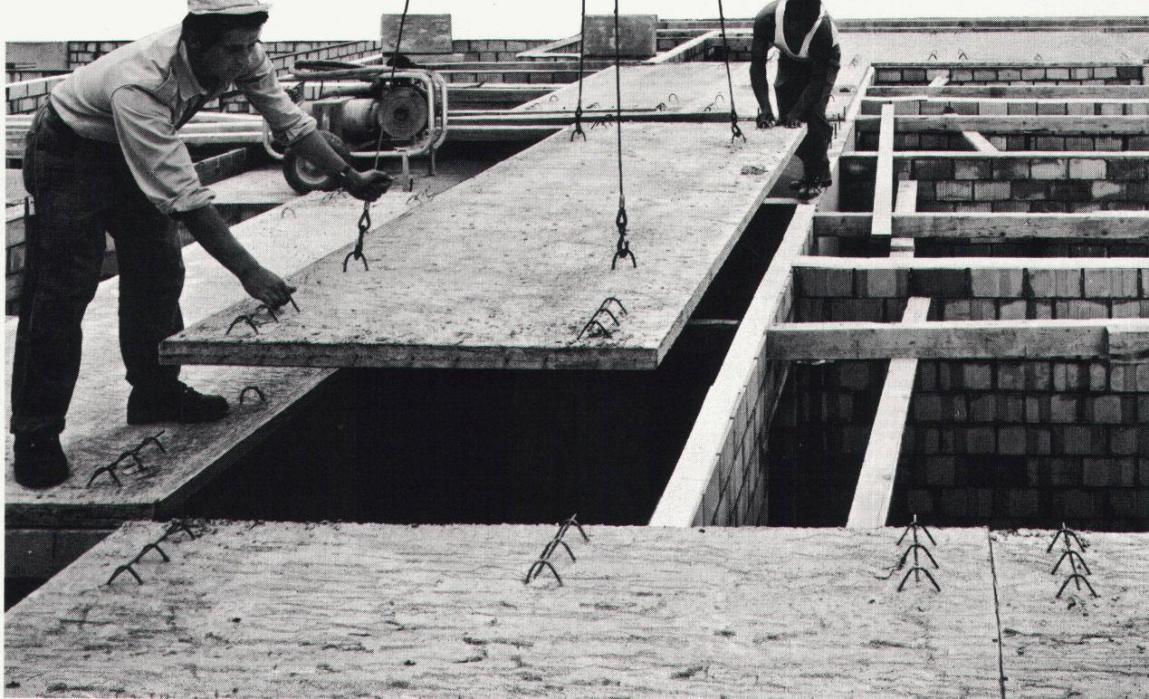
Prelam Deckenplatten sind vorfabriziert und werden am Bau verlegt. Sie übernehmen die Funktion der Deckenschalung und wirken als Träger der vorgespannten Hauptarmierung.
