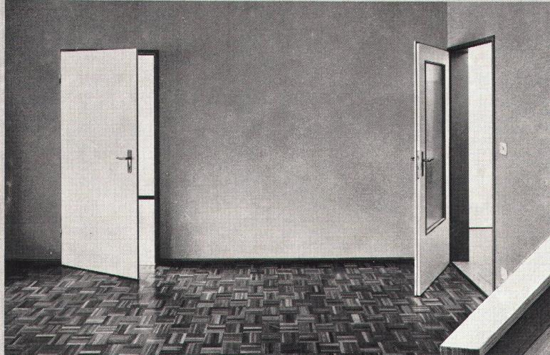
Im Detail bedeutet Wernle-Qualität zum Beispiel: Dieses Türfutter wurde in unserer eigenen Konstruktions-Abteilung entwickelt. Das Besondere: Massdifferenzen im Mauerwerk können in einem Toleranzbereich von 15 mm ohne Nacharbeit ausgeglichen werden.
