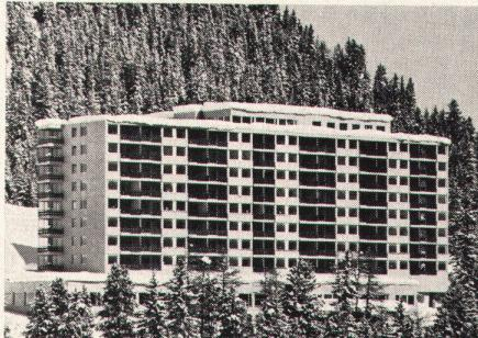
Ein Luxushotel vom Tschuggenformat stellt wirklich seltene Probleme an die Heizung und Warmwasserbereitung. Eine Aufzählung der Wärmeabnehmer zeigt schon die Abhängigkeit des ganzen Hotelbetriebes von den Wärmeerzeugern: Raumheizung, Lüftung, Schwimmbad, Warmwasserbereitung, Kippkessel in der Küche: Total 2 100 000 kcal/h Wärmebedarf.
