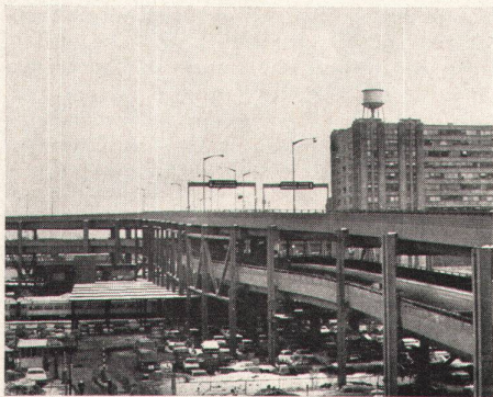
Detailaufnahme der Hochstraße im Bereich des Bahnhofes Photo: Alfred Messerli, Zürich
