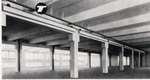
Großlager in Fertigbauweise, Deckenverlegung mit Aris
