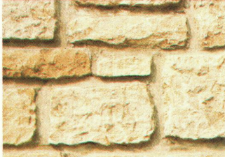
regelmässigem Bruchsteinmauerwerk
