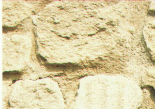
unregelmässigem Bruchsteinmauerwerk
