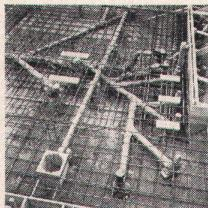
zu montieren. Eine Auswahl an verschiedenen Kupplungen bietet Gewähr für dichte Leitungen. Wünschen Sie Vorfabrication? Unser Technischer Dienst berät Sie gerne. Die glatte Innenwand der Rohre verhindert das Verkrusten und erschwert damit Verstopfungen. Die Dilatation ist ge-
