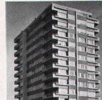
Die wasserdichte, frostbeständige und hinterlüftete Wetterhaut aus ebenen Platten ETERNIT benötigt keinen Unterhalt. Sie bildet einen optimalen Wetterschutz und garantiert über alle Jahreszeiten einen gleichbleibenden Isolierwert.
