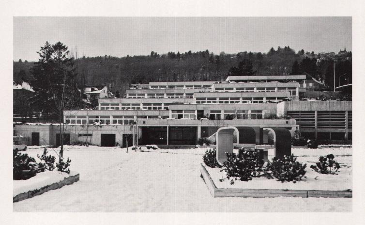
Die Primarschule mit 12 Klassenzimmern, Kleinturnhalle und Doppelkindergarten an der Walkermatte in Biel mußte ein steiles und kleinbemessenes Terrain mittels Stützmauern und Treppen gut ausnützen. Die Dächer der Zivilschutzbauten und des Kindergartens bilden den Sport- und Pausenplatz
