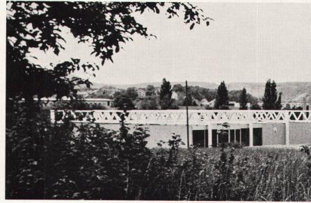
Die erste Etappe der Oberstufenschulanlage Brüel in Gebenstorf umfaßt 8 Klassenzimmer, Bibliothek und 2 Handfertigkeitsräume sowie die zum Turnhallentrakt erweiterbare Turnhalle. Das Hauptgebäude ist eine Stahlkonstruktion mit Fertigelementplatten, die Erschließungstürme mit den Installationen sind aus dem Gebäude herausgenommen und in Massivbauweise erstellt
