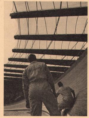
Die überdachte Fläche von 6600 m² besteht aus 56 transluzenten Einzelplanen. Über den Binderpaaren der Holzleimkonstruktion, mit Spannweiten von 18 bis 36 m, befindet sich die transluzente Dachfläche, deren Einzelfelder bei 27 m größter Länge konfektioniert sind.
