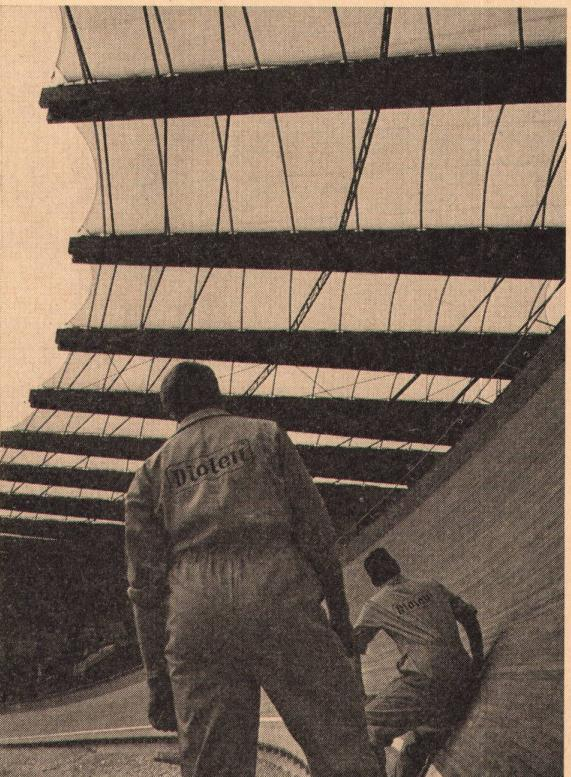
Die überdachte Fläche von 6600 m<sup>2</sup> besteht aus 56 transluzenten Einzelplanen. Über den Binderpaaren der Holzleimkonstruktion, mit Spannweiten von 18 bis 36 m, befindet sich die transluzente Dachfläche, deren Einzelfelder bei 27 m größter Länge konfektioniert sind.
