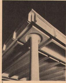
und Deckenplatte. Die Deckenstärke ist konstant und erlaubt den Einbau vertikaler Isolierpaneele einheitlicher Höhe. Die Struktur kann auch im Wohnungsbau angewendet werden, da sie einen vertikalen Aufbau von 300 cm hohen Räumen gewährleistet. Sie wird in gewöhnlichem Stahlbeton produziert und nicht vorgespannt.
