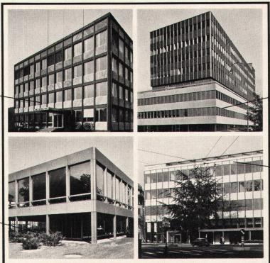
Betriebsgebäude und Bürohochhaus der Galenica AG in Bern: Stahl-Konstruktion mit Profilblech-Decken. Sandwich-Brüstungen mit Grinatalblech verkleidet. Fenster aus Leichtmetall-Profilen. Stützenverkleidungen aus Peralumanblech.
