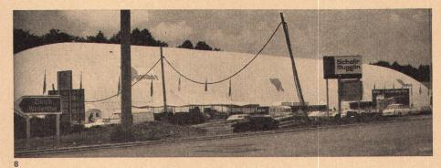
ken gekostet. Die Hülle ist aus einer PVC-beschichteten Chemiefaser hergestellt, sie wiegt 7 Tonnen und wird mittels eines Luftdrucks von 0,003 atü in ihrer Form gehalten.
