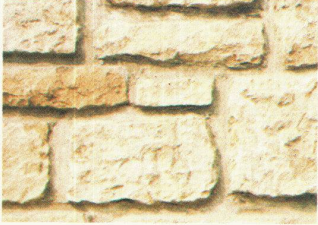
regelmässigem Bruchsteinmauerwerk
