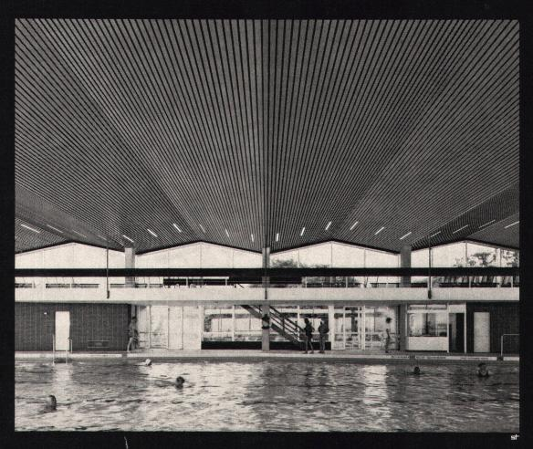
Luxalon® Aluminium-Decken. Das heisst einbrennlackierte Aluminiumpaneele, die auf einbrennlackierte Aluminiumtragschienen geklemmt werden. Dabei stehen unterschiedliche Profilformen zur Wahl. Luxalon® Aluminium-Profilformen zur Wahl. Luxalon® AluminiumDecken. Das heisst hohe Korrosionsfestigkeit.
