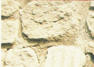
unregelmässigem Bruchsteinmauerwerk
