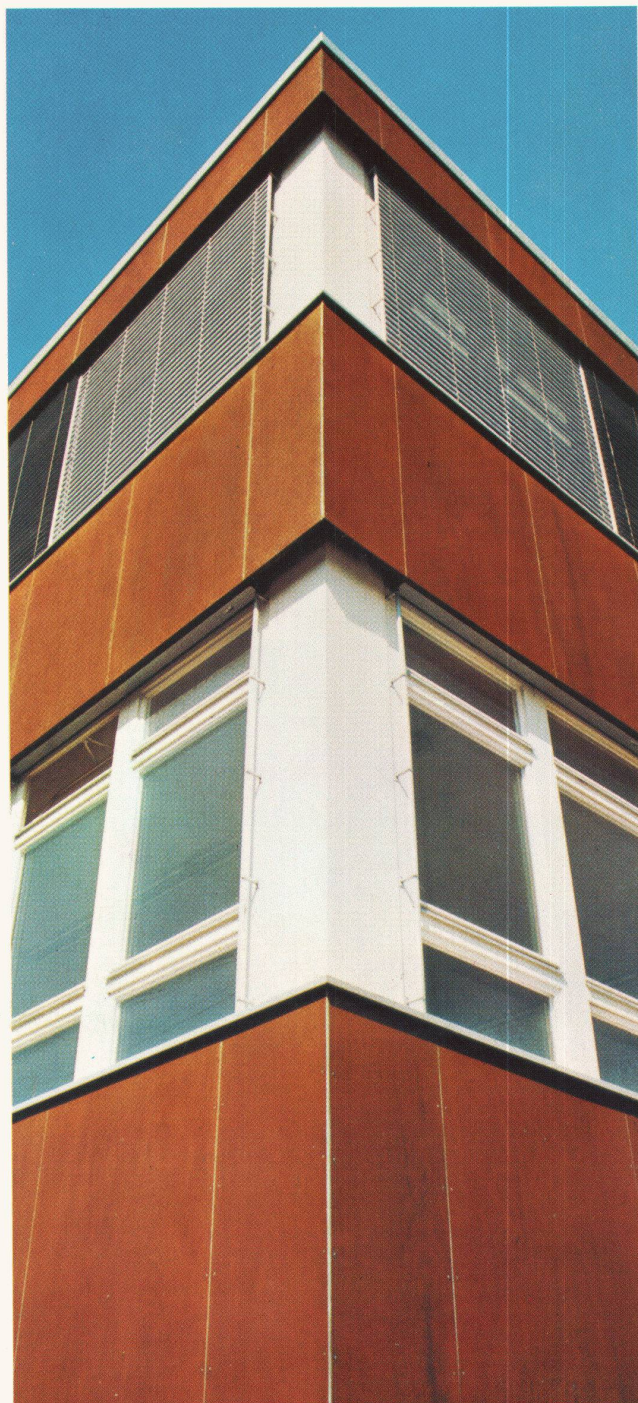
Industriegebäude: Gebr. Gläser AG, Schreinerei, 5513 Dättwil
