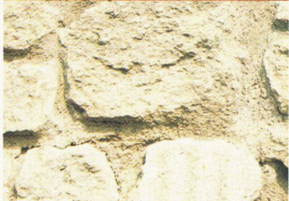
unregelmässigem Bruchsteinmauerwerk
