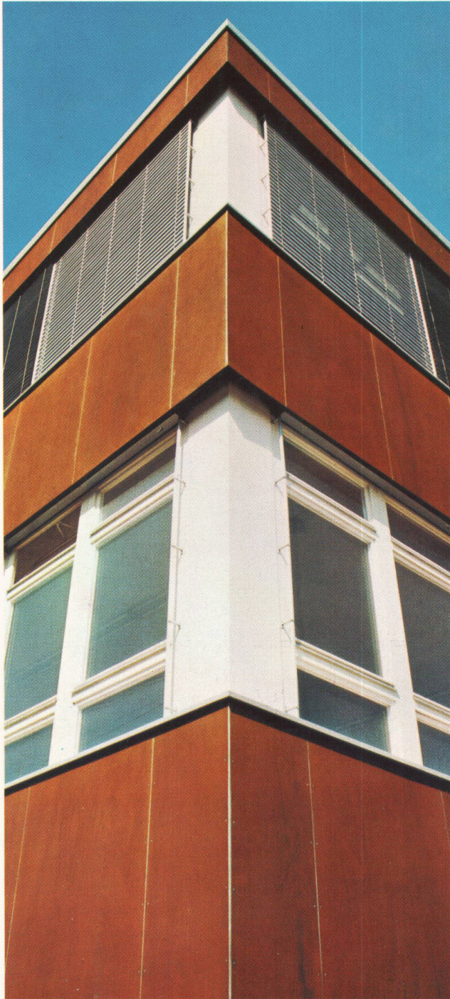
Industriegebäude: Gebr. Gläser AG, Schreinerei, 5513 Dättwil
