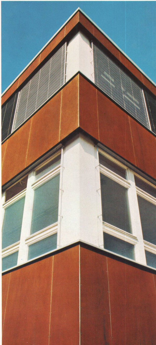
Industriegebäude: Gebr. Gläser AG, Schreinerei, 5513 Dättwil
