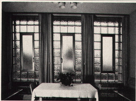
Glasbausteinfenster mit Anticorodal-Drehflügel in Sitzzimmer.
