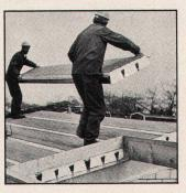
Holorib DLW sind Dachelemente mit maximaler Belastungsfähigkeit, in Längen von 2,5 bis 8,0 m, mit geringem Eigengewicht (20,5 bis 33,5 kg/cm², je nach Beschichtung), mit hoher Isolationsfähigkeit (K-Wert 0.40)
