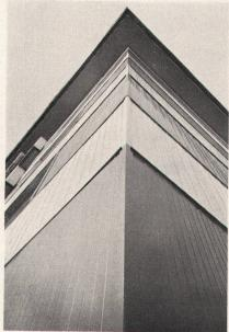
RAUFASSYT ist eine zweischalige, vorgehängte Fassade. Die Luftschicht zwischen Fassade und Wand verhindert Schwitzwasser und Kältebrücken. Heizkosten werden gespart.
