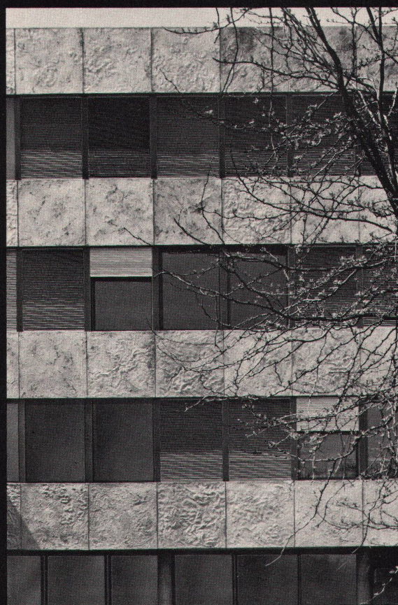
Bürogebäude Bernina, Steckborn
