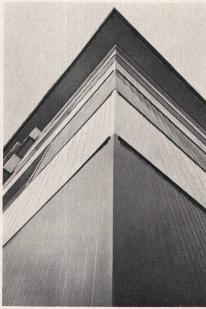
RAUFASSYT ist eine zweischalige, vorgehängte Fassade. Die Luftschicht zwischen Fassade und Wand verhindert Schwitzwasser und Kältebrücken. Heizkosten werden gespart.
