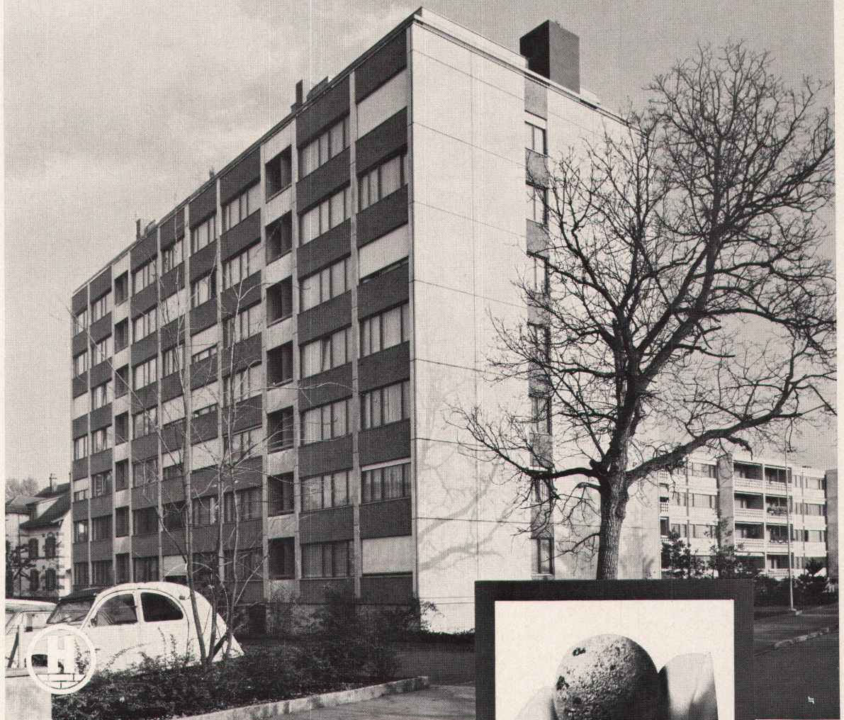
Wohnüberbauung mit in Feldvorfabrikation hergestellten Leca -Fassadenelementen Architekt: R. Moeri, Lyss Ingenieur: H. J. Wyss, Biel Bauausführung: R. Moeri + Co., Bauunternehmung, Lyss
