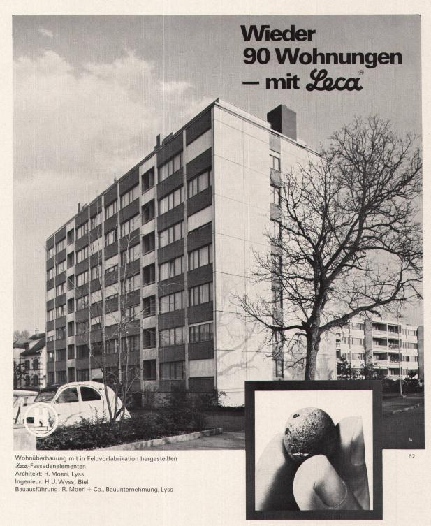
Die Vorfabrikation kann so entscheidende Vorteile bieten, dass diese zeitsparende Bauweise auch im Wohnungsbau bei grösseren Objekten stets in Betracht zu ziehen ist. Oft geben aber Isolationsschwierigkeiten den Ausschlag zugunsten des konventionellen Baus.
