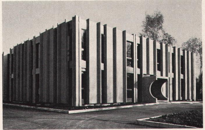
In einem einzigen Gebäude sind die Büro-, Fabrikations- und Lagerräume eines Wein- und Spirituosenunternehmens untergebracht. Träger und Deckenplatten des Hallenbaus für die Fabrikation und das Lager sind vorfabrizierte, vorgespannte Betonelemente. Ebenfalls vorfabriziert und aus Beton sind die U-förmigen Fassadenplatten, die abwechselnd mit verglasten Streifen die Außenflächen des langgestreckten Volumens strukturieren
