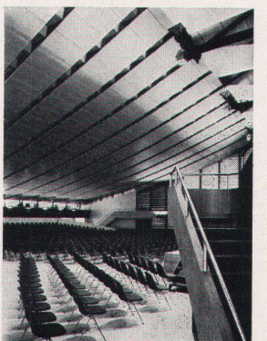
Konzertsaal Schrägwand, Vertikalschnitt Elemente aus NOVOPAN 40 mm, furniert und NOVOPAN Hängedekke ◀
