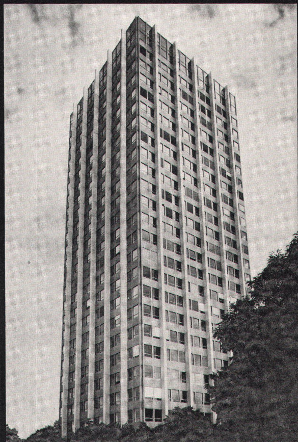
Bürogebäude Sulzer, Winterthur
