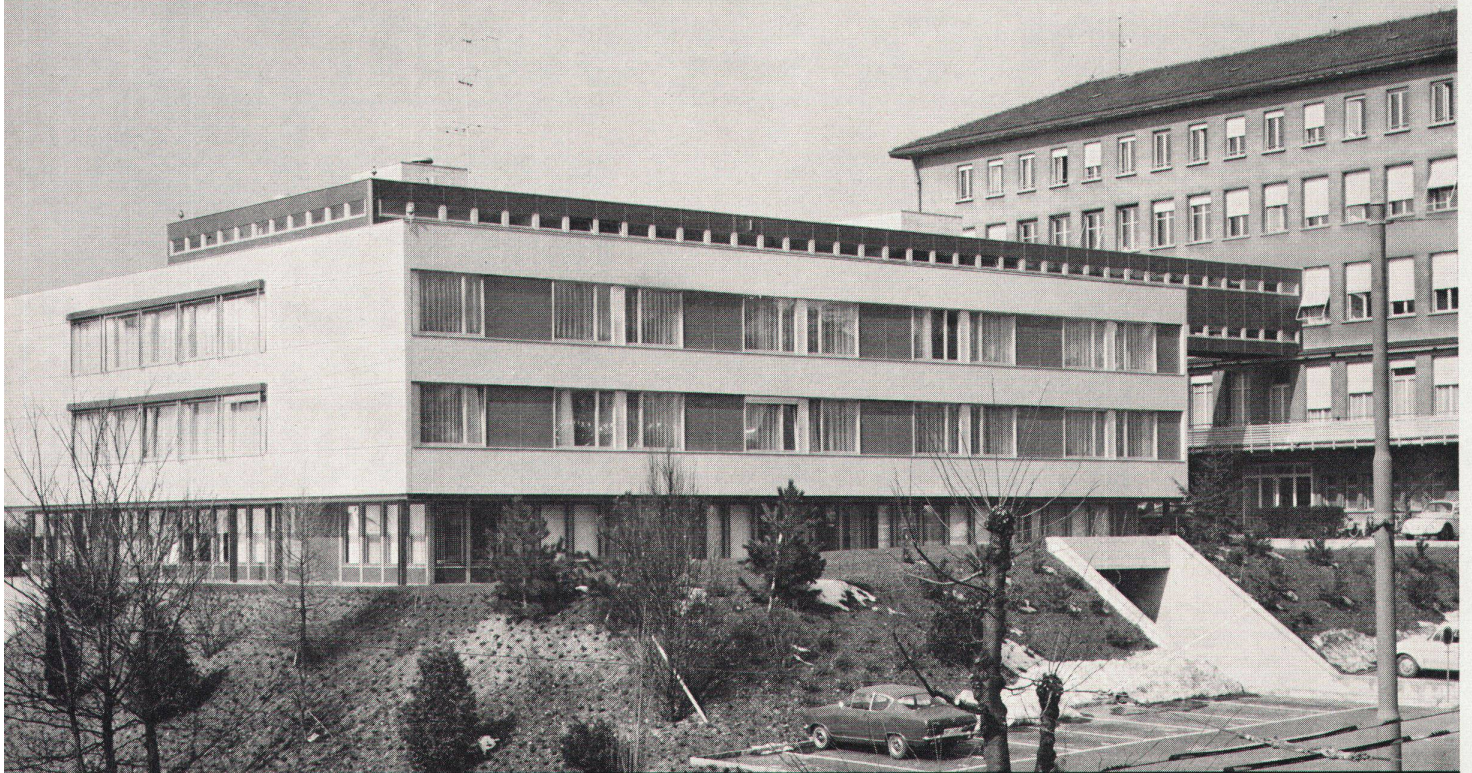
Kantonsspital Lausanne Anbau Chirurgietrakt Architekten: HH. P. Bonnard, J.P. Cahen, J. Lonchamp, Lausanne
