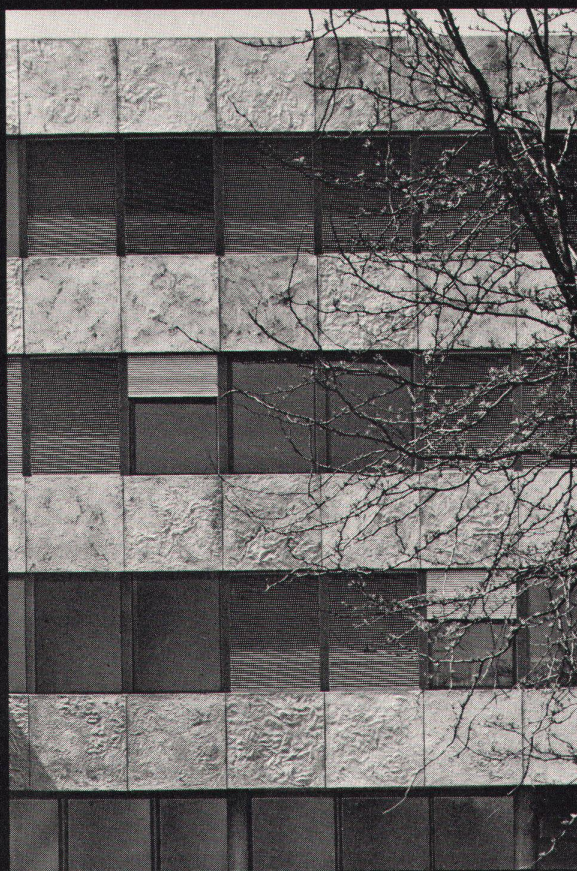
Bürogebäude Bernina, Steckborn
