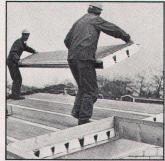
Holorib DLW sind Dachelemente mit maximaler Belastungsfähigkeit, in Längen von 2,5 bis 8,0 m, mit geringem Eigengewicht (20,5 bis 33,5 kg/cm², je nach Beschichtung), mit hoher Isolationsfähigkeit (K-Wert 0.40)
