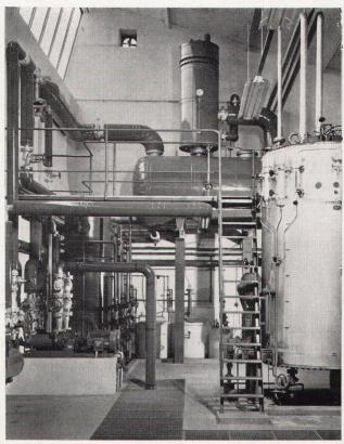
8903 Birmensdorf-Zürich, Tel. 051/954711 Aufbereitungs-Anlage für einen Mitteldruck-Kessel
