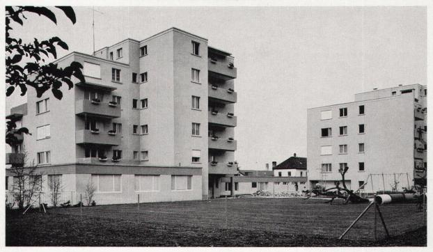
Die Fassaden dieser neuen Überbauung in Fällanden ZH sind mit Polyton Fassadenputz beschichtet. Dadurch konnte die Bauzeit verkürzt werden. Um die Wartezeit nämlich, die man bei einem konventionellen Putz bis zum Auftragen des Dispersions-Anstriches hätte einhalten müssen. Denn Polyton-Anstriche werden aufgezogen (links) und gleich darauf abgerieben (rechts). Ein nachträglicher Anstrich erübrigt sich. Polyton Fassadenputze werden verarbeitungsbereit ge-
