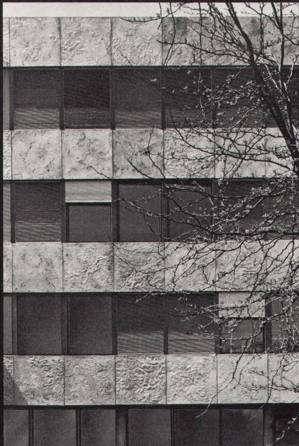
Bürogebäude Bernina, Steckborn
