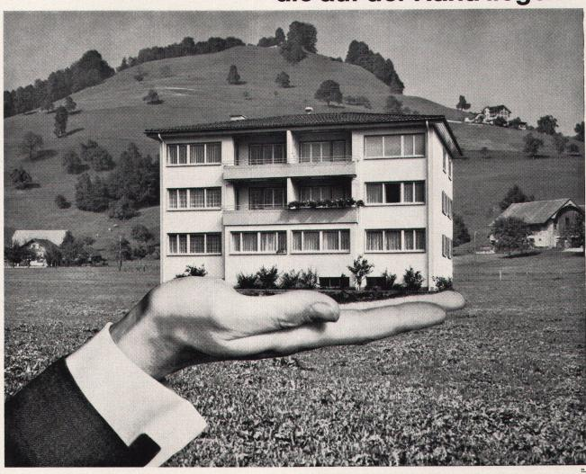
Hochwertige Materialien mit ausgezeichneten Isoliereigenschaften führen zu immer leichteren Bauelementen. Durch die Einsparungen möglich werden: beim Gewicht der Konstruktionen – bei der Bauzeit – bei den Baukosten. Wie bei diesem Haus, bei dem für die Fassadenwände Holzwolle-Leichtbauplatten und Beton miteinander kombiniert wurden (Mantelbetonweise). Im Kern
