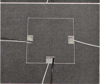
dazu passender Boden-Verbindungskanal: 3zügig, 200 mm breit, 30 mm hoch Pat. ang.
