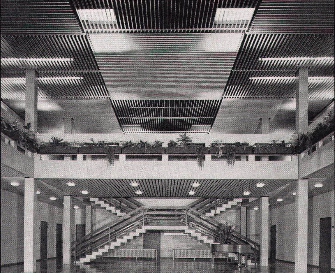
Luxalon® Aluminium-Decken. Das heisst einbrennlackierte Aluminiumpaneale, die auf einbrennlackierte Aluminiumtragschienen geklemmt werden. Dabei stehen unterschiedliche Profilformen zur Wahl. Luxalon® Aluminium-Decken. Das heisst hohe Korrosionsfestigkeit. Einfache und schnelle Montage, bietet vielfältige Gestaltungsmöglichkeiten. Leitungen und Installationen bleiben also immer zugänglich. Und noch ein Vorteil: Luxalon® Aluminium-Decken sind in verschiedenen Farben erhältlich.
