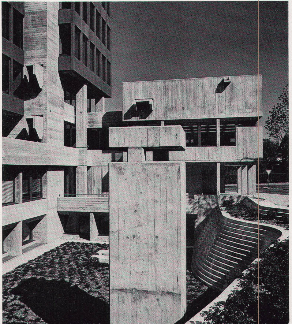
10 9 Restaurant-cantine 10 Cour-jardin de l'immeuble administratif 11, 12 Immeuble du tribunal et escalier
