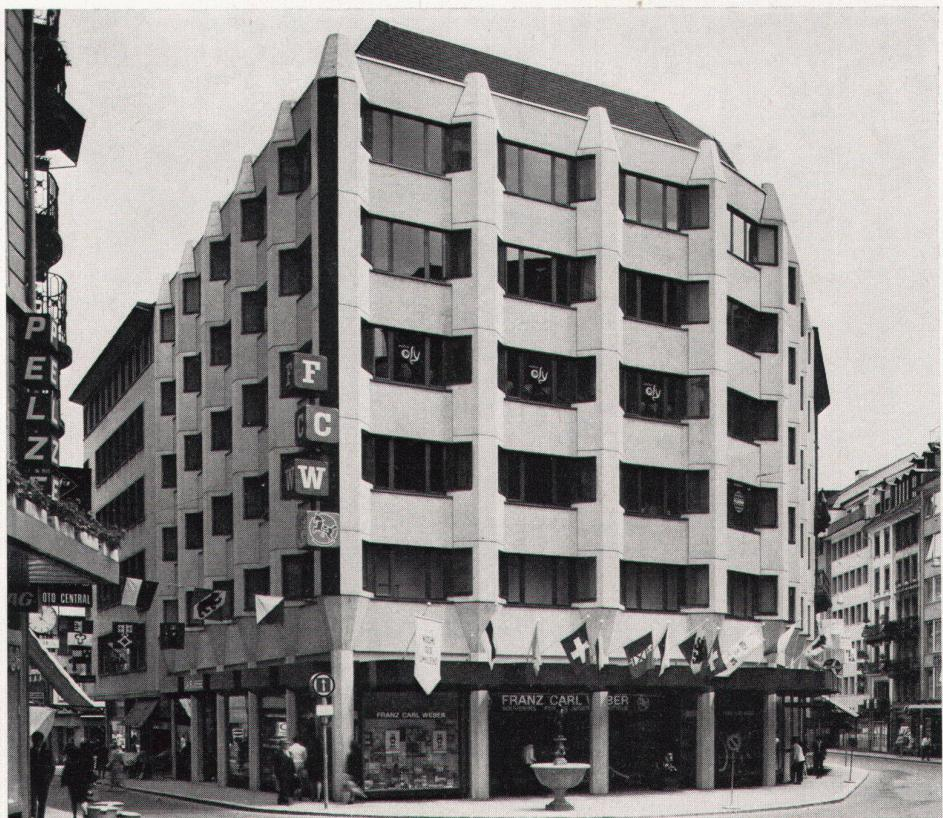
Das Mehrzweckgebäude an der meistbegangenen Gasse von Luzern enthält in der Passage und in drei Obergeschossen Läden, darüber Büros und Praxisräume; in der Dachwohnung etablierte sich ein Innenarchitekt. Eisenbetonskelettbau mit vorfabrizierten plastischen Fassadenelementen, vertikalen Klimakanälen an der Fassade und einem exzentrischen Erschließungskern.
