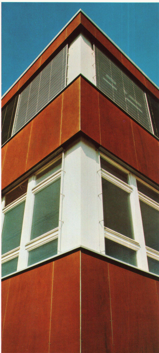
Industriegebäude: Gebr. Gläser AG, Schreinerei, 5513 Dättwil
