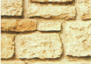
regelmäßigem Bruchsteinmauerwerk
