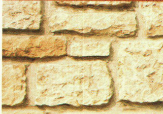
regelmässiges Bruchsteinmauerwerk
