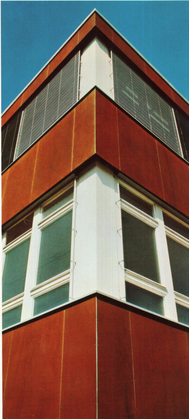
Industriegebäude: Gebr. Gläser AG, Schreinerei, 5513 Dättwil
