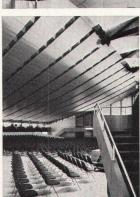
Konzertsaal Schrägwand, Vertikalschnitt Elemente aus NOVOPAN 40 mm, furniert und NOVOPAN Hängedecke
