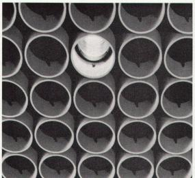
Die Beleuchtungskörper, Ø zirka 18 cm, wurden direkt im Diagonalschnittpunkt der Rasterfelder in die Rohrstücke eingebaut.
