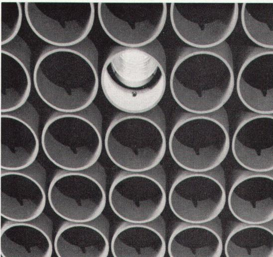
Die Beleuchtungskörper, Ø zirka 18 cm, wurden direkt im Diagonalschnittpunkt der Rasterfelder in die Rohrstücke eingebaut.
