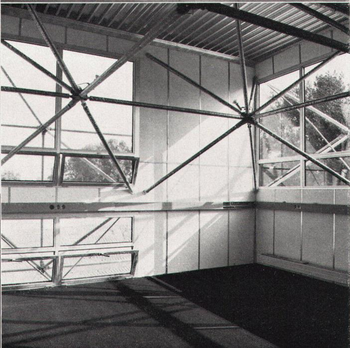
Die Tragkonstruktion der Lagerhalle mit Bürogebäude ist als räumliches Fachwerksystem für oberen und seitlichen Raumabschluß aus Varitec-Standardelementen ausgeführt. Das horizontale Sturzband und der Dachkranz sind hinter der sichtbaren Tragkonstruktion montiert. Die Fassadenverkleidung besteht aus Aluminiumprofilblech und Schichttex-Isolierplatten. Die Aluminiumfenster sind farblos eloxiert und mit wärmeabsorbierendem Thermopane-Grauglas in Neoprene-Profildichtungen trocken verglast
