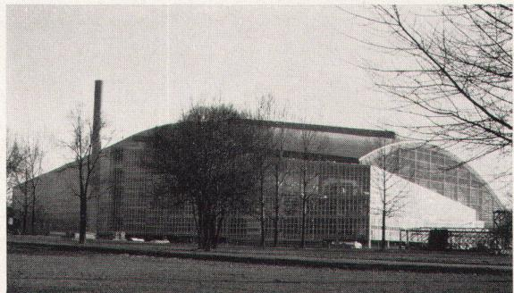
Treize fermes, constituées par des arcs à double articulation en bois lamellé collé, couvrent la glace et les tribunes de la patinoire artificielle de l'Allmend à Berne. Des sous-tirants précontraints reprennent les poussées horizontales des arcs. La toiture se compose de plaques ondulées translucides en PVC
