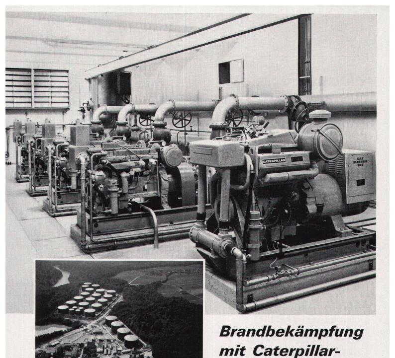
Im Falle einer Brandkatastrophe stehen der Tankanlage Mellingen vier mit Wasserpumpen gekuppelte Caterpillar-Dieselmotoren für die Berieselung der Brennstofftanks zur Verfügung. Ihre stündliche Pumpleistung beträgt 1,2 Mio Liter bei 110 m WS Druck.
