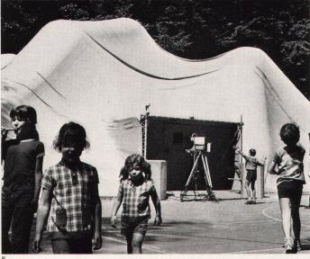
4 Der Informationspavillon ist eine einfache Tragluftkonstruktion mit Betonbeschwerung und enthält Informationsmittel wie Telex, Vervielfältigungsapparate, Kurzwellensender
