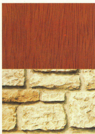
regelmässiges Bruchsteinmauerwerk
