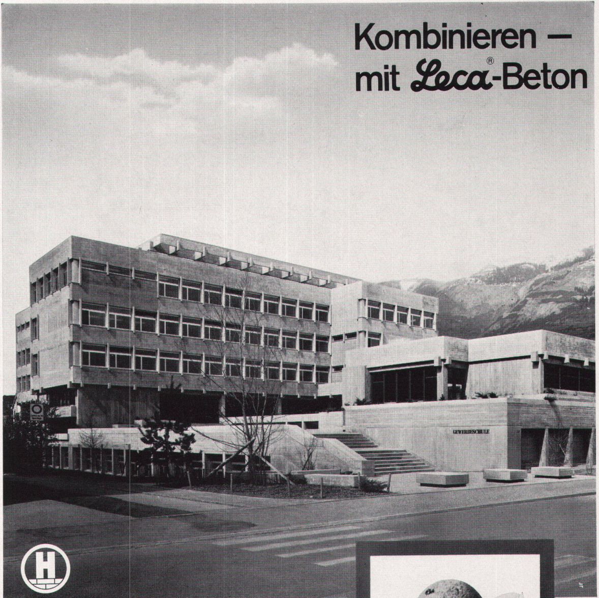
Gewerbeschulhaus Chur; seine Fassaden und Dachaufbauten sind —teils an Ort geschüttet, teils vorfabriziert— in Leca - und Normalbeton ausgeführt. Planung: A. Liesch, dipl. Architekt BSA/SIA Statik: Jenatsch + Hegland, Ingenieure, Chur
