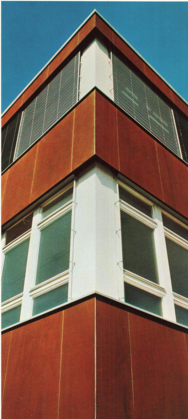
Industriegebäude: Gebr. Gläser AG, Schreinerei, 5513 Dättwil
