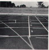
Die Oberflächenbehandlung kann bei diesen Belägen variiert werden. Markierungen sind widerstandsfähig und können individuell in verschiedenen Farben angebracht werden. RUB TAN ist spikesfest.
