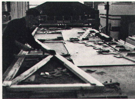
Produktions- und Montagephasen und Transport von Modular Homes. Es besteht die Tendenz, möglichst große Fabrikationsteile herzustellen; die obere Grenze ist durch die Transportvorschriften determiniert
