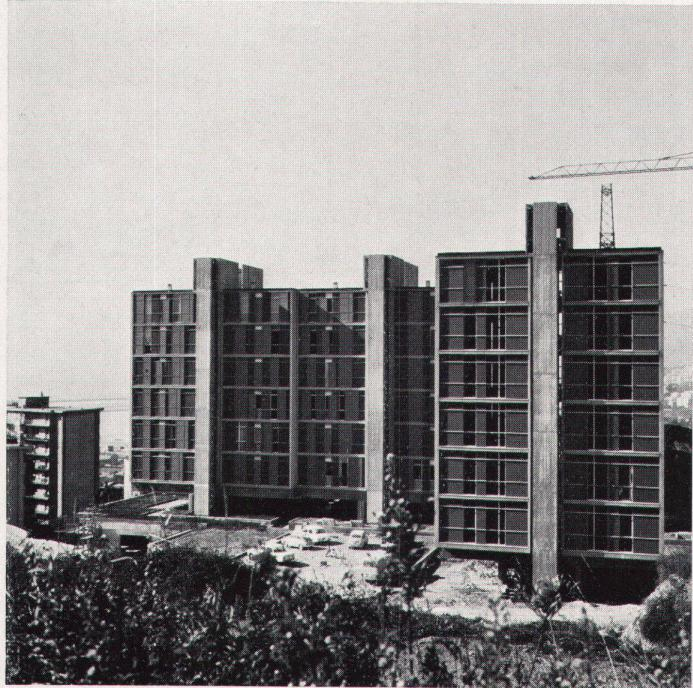
Die undurchsichtigen Außenwände der Wohnungen sind Sandwichplatten mit Kunststofffüllung und nach außen mit einem undurchlässigen Granulat bestrichen; dazwischen sind vom Boden zur Decke durchgehende Fensterwände mit verschiebbaren Läden
