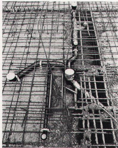
Im Jahrzehntelangen täglichen Gebrauch widersteht es der Korrosion, heißem Wasser und Eis, Lösungsmitteln und fast allen Chemikalien, ja sogar radioaktiven Abwässern.
