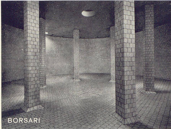
Flughafen-Immobilien-Gesellschaft Zürich-Kloten 7 Tanks total 5600 m 3 Schweröl
