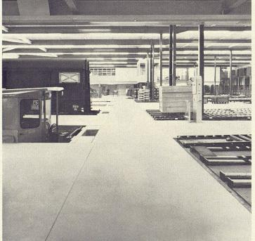
KIESERLING Spezial-Betonbelag ausserordentliche Härte, beständig gegen Fette, Blut, Fäkalien, Benzin, Oel, leichte Reinhaltung
