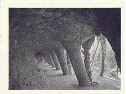
Gedeckte Galerie im Park Güell. Die schräggestellten Pfeiler folgen der Richtung der Druckkräfte und des Gewölbeschubes. Sie zeigen die Statik der Konstruktion mittels schwerem, am Bauplatz gebrochenem Stein. Architekt: Antoni Gaudi
